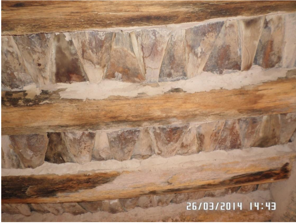
الصورة رقم 174 : التسقيف بواسطة الكرناف في قصر تاغيت ( عن الطالب )
