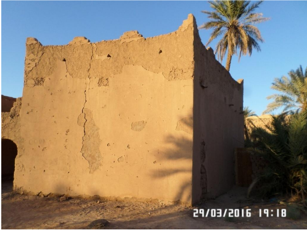
الصورة رقم 98 : برج المراقبة بالجهة الشرقية قصر بني عباس ( عن الطالب )
