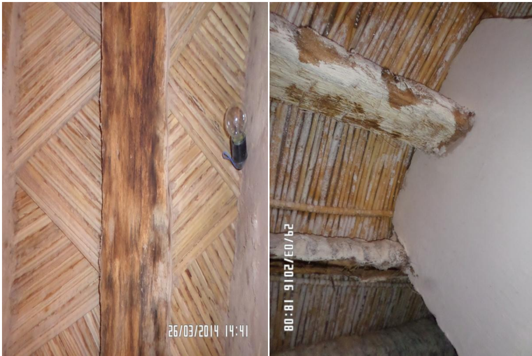
الصورة رقم 165 : استعمال القصب في التسقيف بالقصرين ( عن الطالب )
