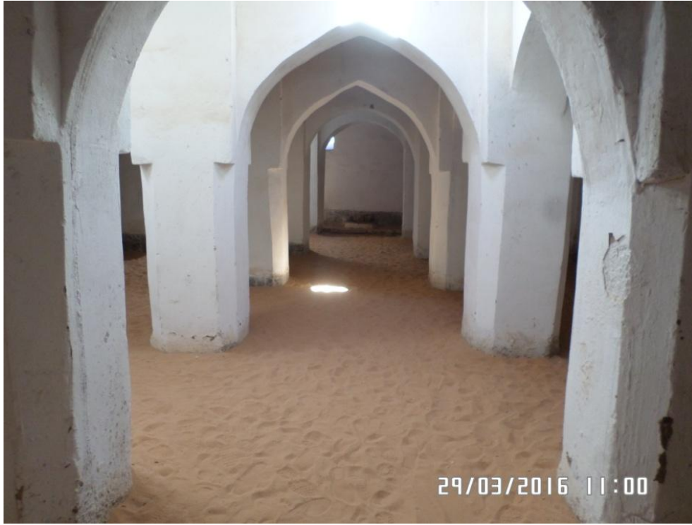
الصورة رقم 154 : أنواع العقود بمسجد قصر بني عباس ( عن الطالب )
