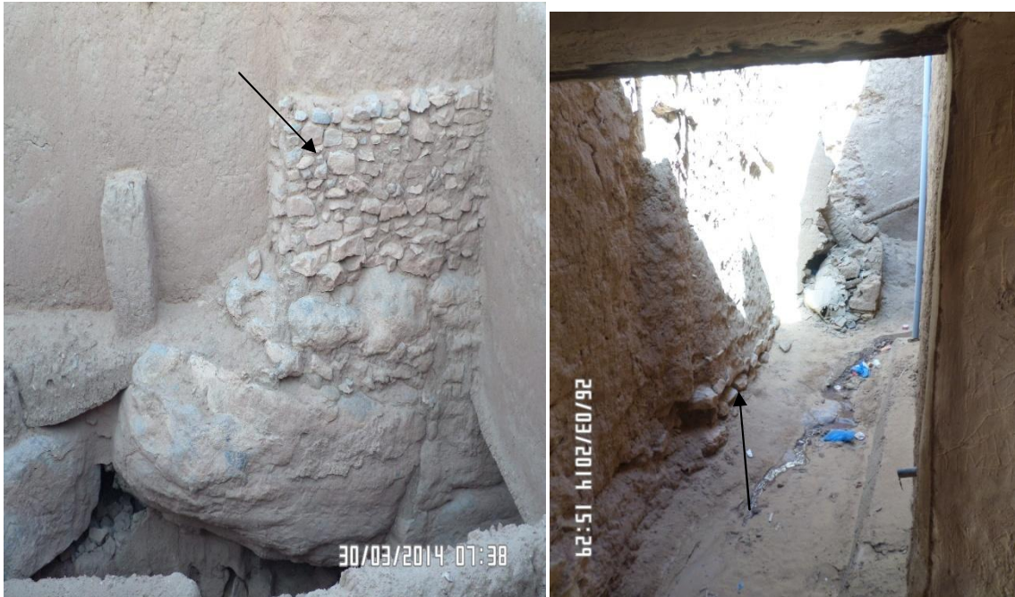
الصورة رقم 171: طريقة بناء الأساسات بمنزل قصر تاغيت ( عن الطالب )
