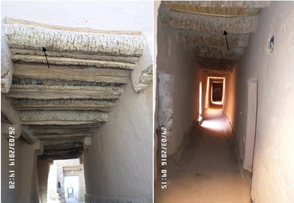
الصورة رقم 163 : استعمال خشب النخيل في التسقيف بالقصرين ( عن الطالب )
