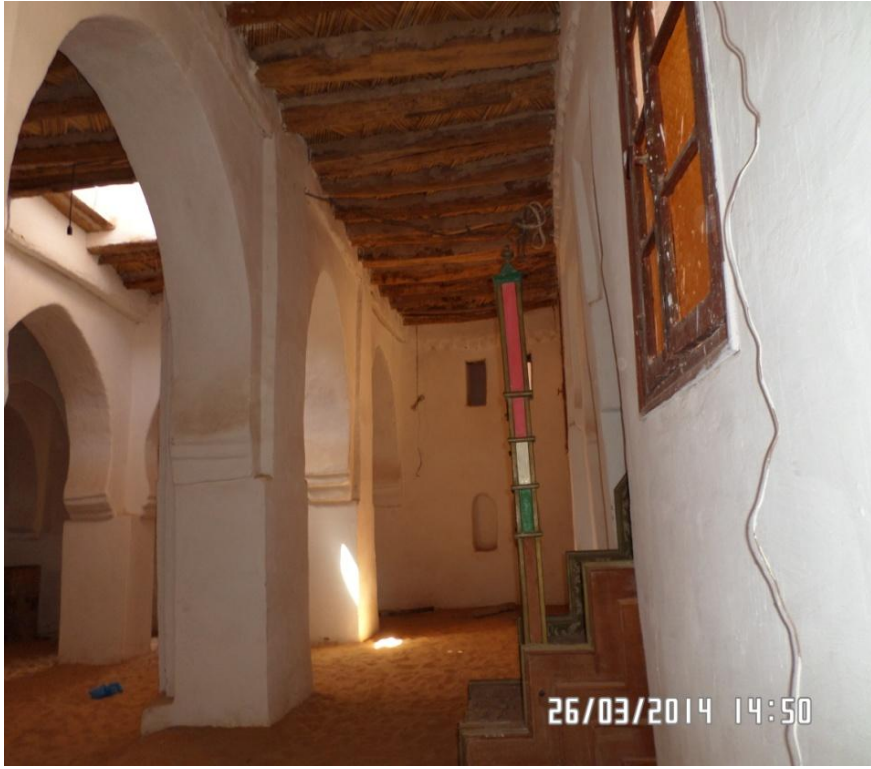
الصورة رقم 114 : البائكة ببيت الصلاة بمسجد قصر تاغيت ( عن الطالب )
