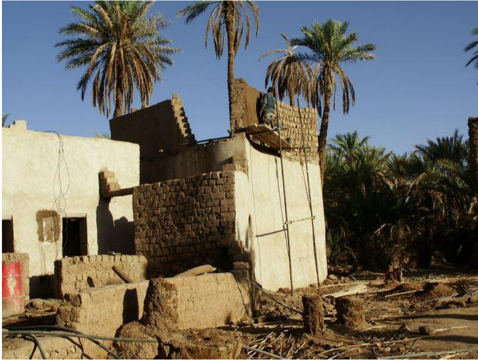
الصورة رقم 102: عملية ترميم برج المراقبة قصر بني عباس ( عن جمعية القصر)
