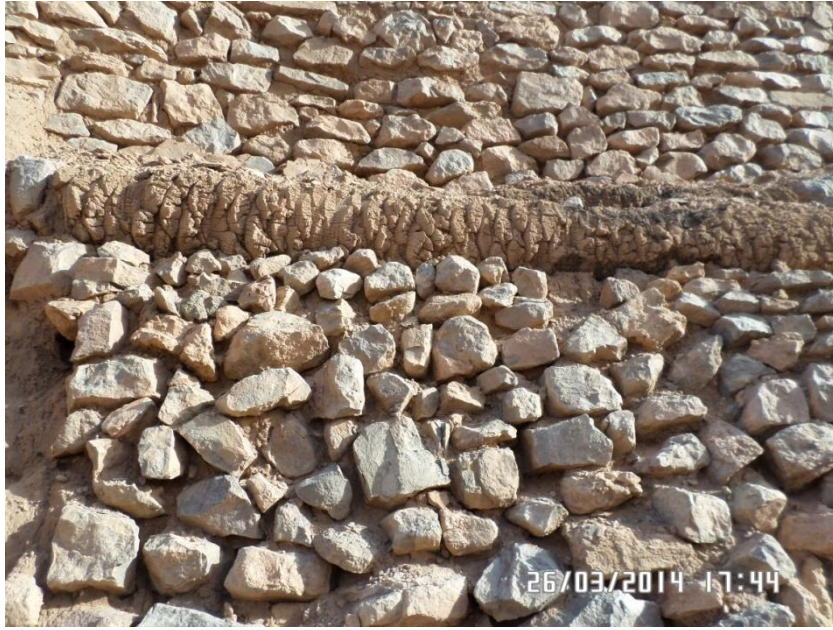
الصورة رقم 168: طريقة المداميك بالحجارة بقصر تاغيت ( عن الطالب )
