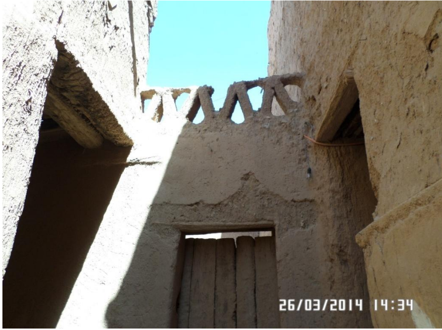
الصورة رقم 182 : شرافات هرمية مفتوحة بقصر تاغيت ( عن الطالب )
