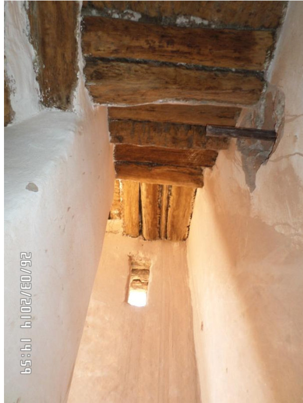
الصورة رقم 139 : التسقيف بمنذنة بالمسجد قصر تاغيت ( عن الطالب )
