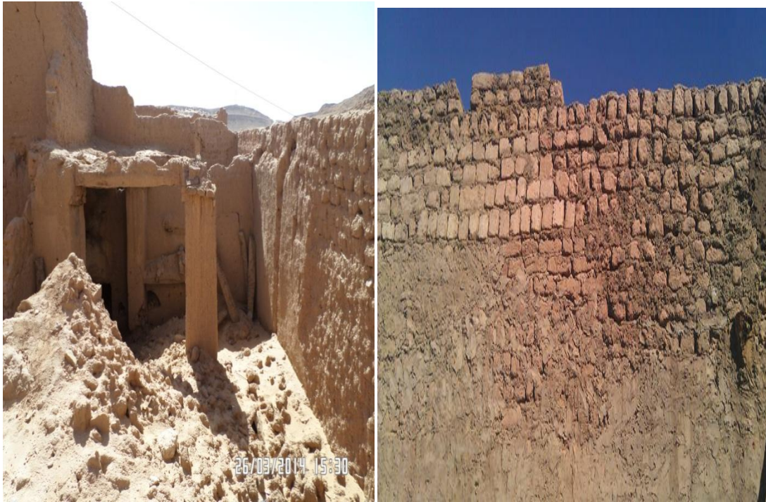
الصورة رقم 167: طريقة المداميك بالطوب بقصر تاغيت ( عن الطالب )
