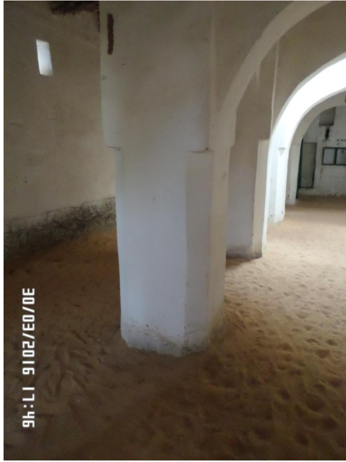
الصورة رقم 152 : الدعامات المثلثة بمسجد قصر بني عباس ( عن الطالب )
