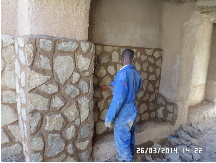
الصورة رقم 160 : استعمال الحجارة اسفل الجدران بقصر تاغيت ( عن الطالب )
