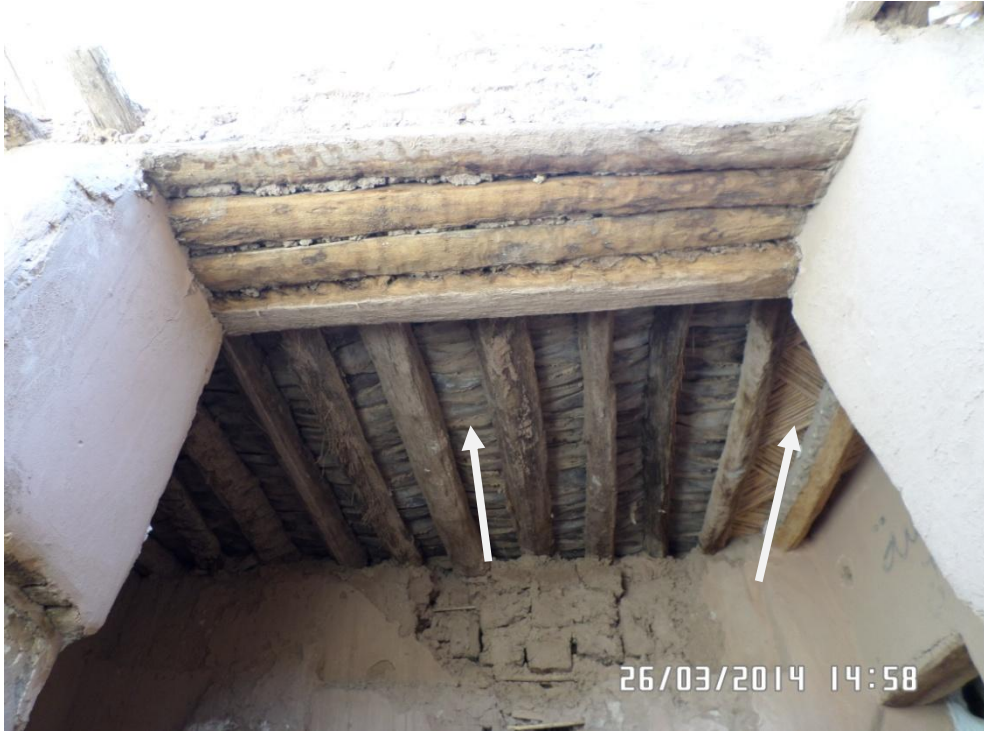
الصورة رقم 175 : التسقيف الممزوج في قصر تاغيت ( عن الطالب )
