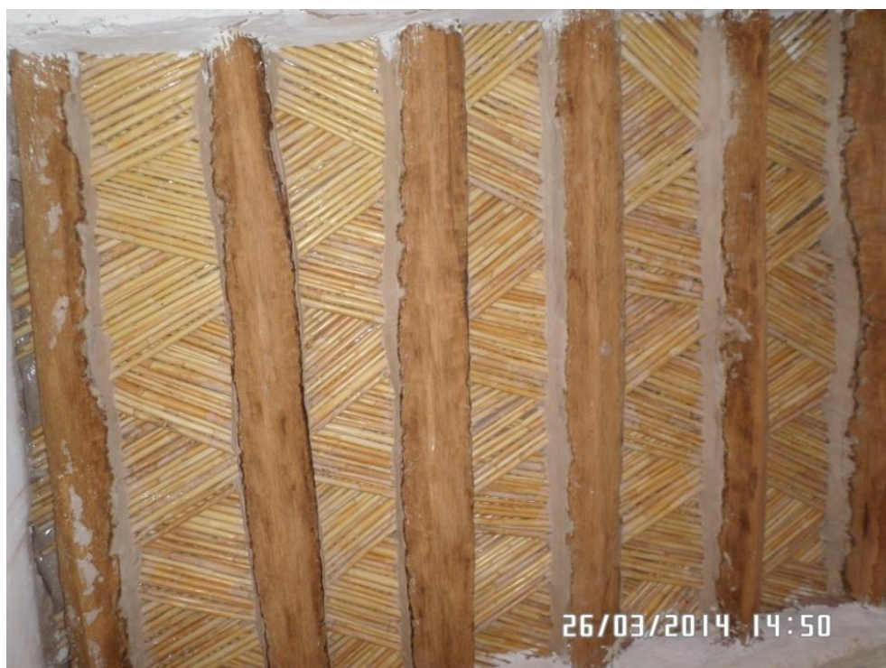
الصورة رقم 127 : التسقيف ببيت الصلاة بمسجد قصر تاغيت ( عن الطالب )
