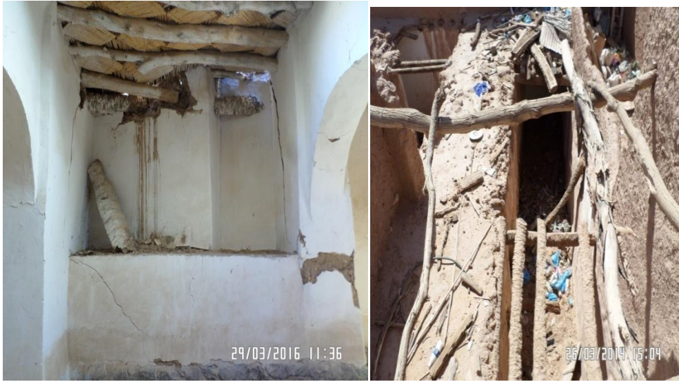
الصورة رقم 164: استعمال خشب الصفصاف في التسقيف بالقصرين ( عن الطالب )
