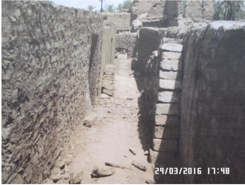
الصورة رقم 166: طريقة المداميك بالطوب بقصر بني عباس ( عن الطالب )
