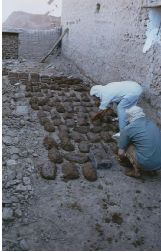
الصورة رقم 158: تشكيل الطوب باليد و القالب ( عن جمعية قصر تاغيت)
