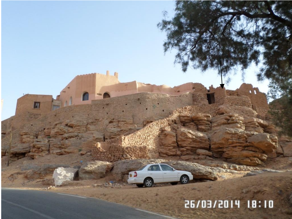
الصورة رقم 97: بقايا البرج بالجهة الشمالية عند المدخل الشمالي قصر تاغيت ( عن الطالب )
