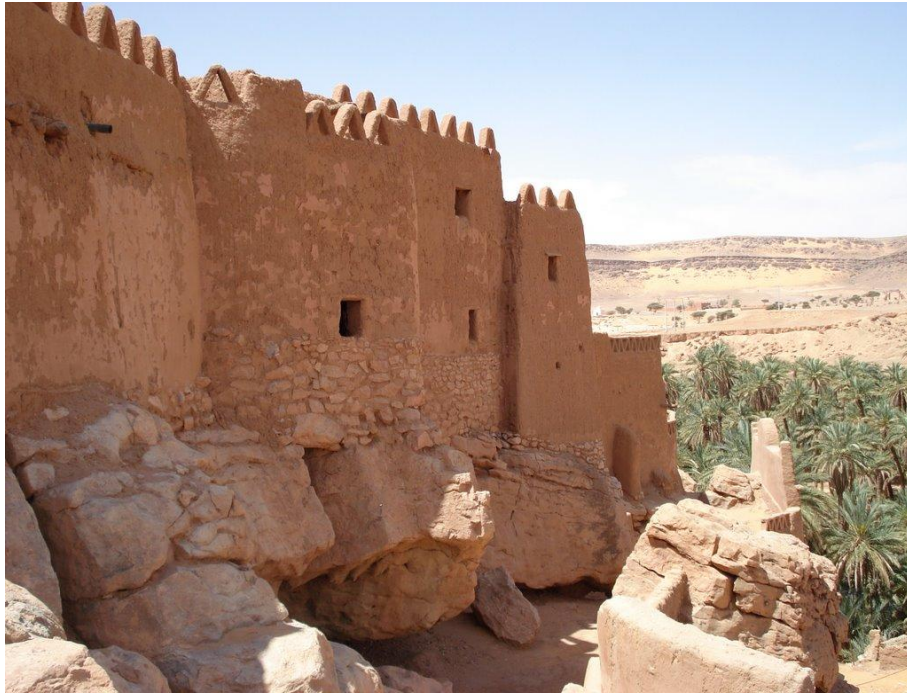
الصورة رقم 183: شرافات هرمية مفتوحة بالجهة الشمالية الغربية بقصر تاغيت ( عن الطالب )
