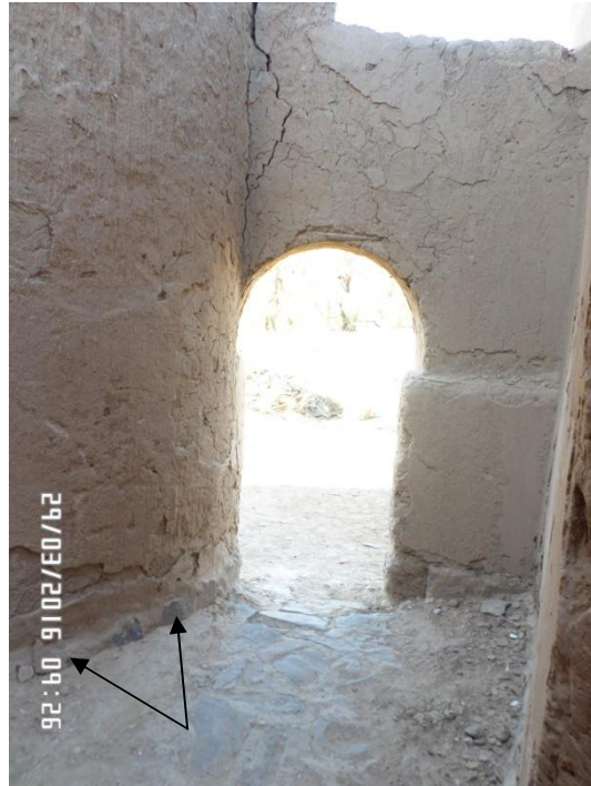
الصورة رقم 173: استعمال الحجارة في بناء الأساسات بمنزل قصر بني عباس ( عن الطالب )
