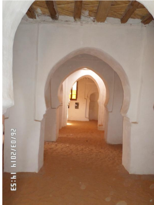
الصورة رقم 149 : الدعامات المستطيلة بمسجد قصر تاغيت (عن الطالب)
