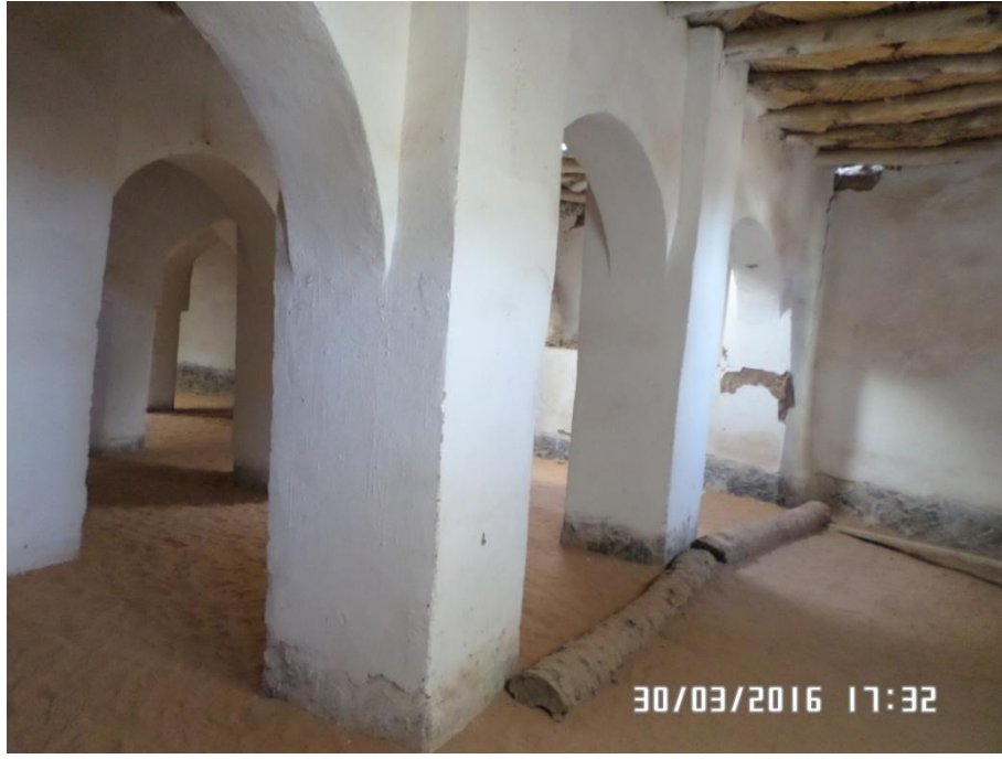
الصورة رقم 150: الدعامات المستطيلة بمسجد قصر بني عباس ( عن الطالب )
