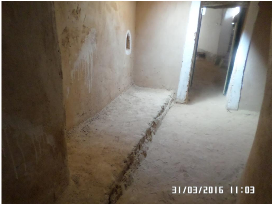
الصورة رقم 117 : المدخل الرئيسي لبيت الصلاة بمسجد قصر بني عباس ( عن الطالب )
