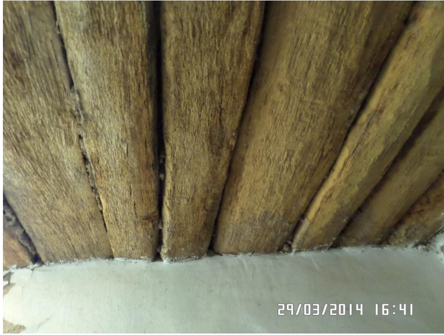
الصورة رقم 176: التسقيف الملطوم في قصر تاغيت ( عن الطالب )
