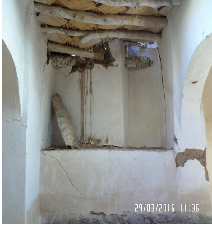
الصورة رقم 140 : مكان تواجد سلم الصعود لسطح مسجد قصر بني عباس ( عن الطالب )
