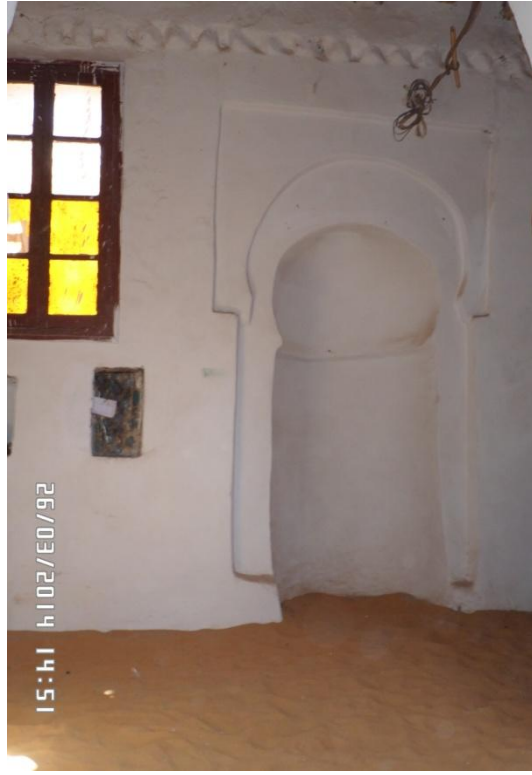
الصورة رقم 128: المحراب ببيت الصلاة بمسجد قصر تاغيت ( عن الطالب )
