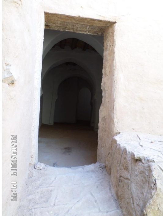
الصورة رقم 111: المدخل الشرقي لبيت الصلاة بمسجد قصر تاغيت ( عن الطالب )
