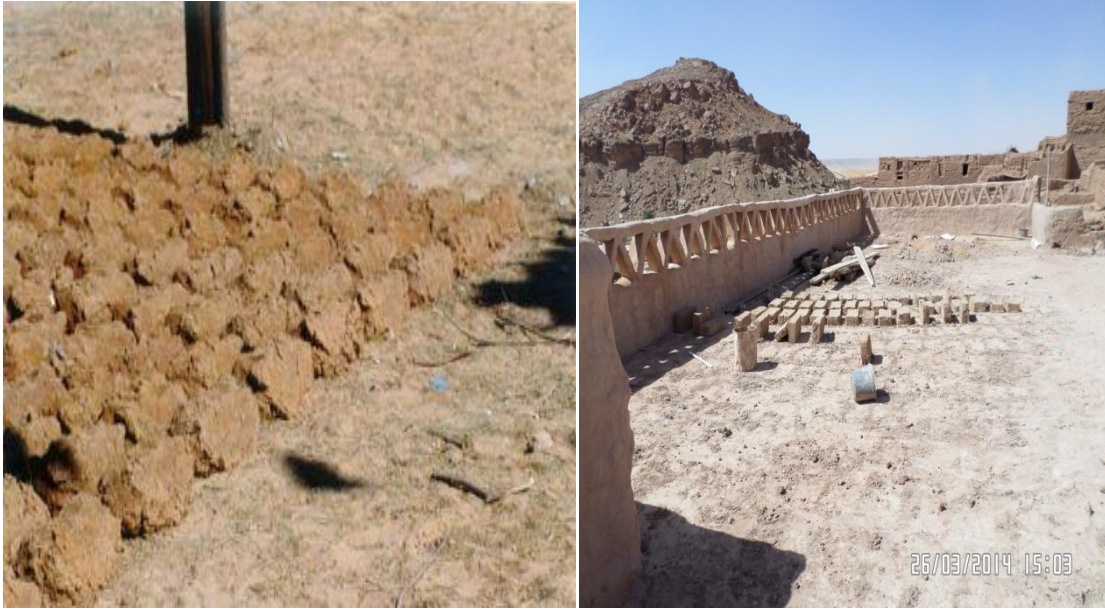
الصورة رقم 159: تجفيف الطوب ( عن الطالب) و ( عن جمعية قصر تاغيت)
