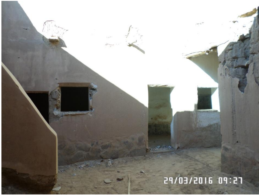
الصورة رقم 48 : صحن احد المنازل بقصر بني عباس ( عن الطالب)
